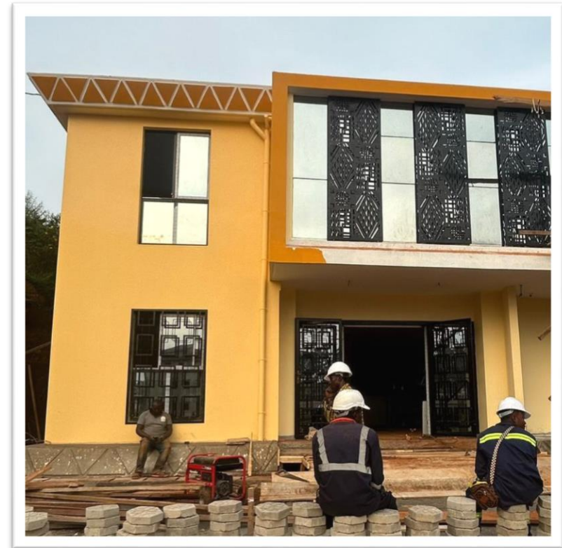
Une vue du bâtiment en cours de finalisation
