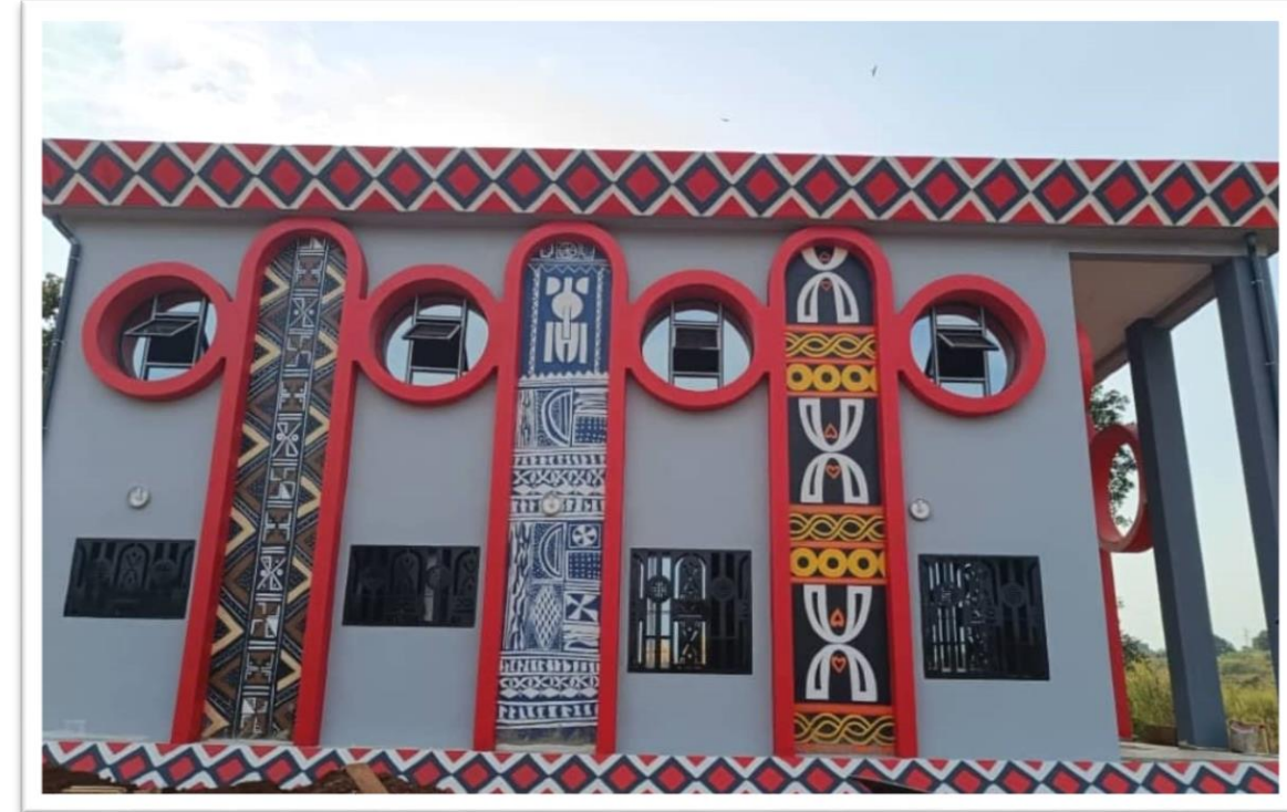
Une vue du bâtiment en cours de finalisation
